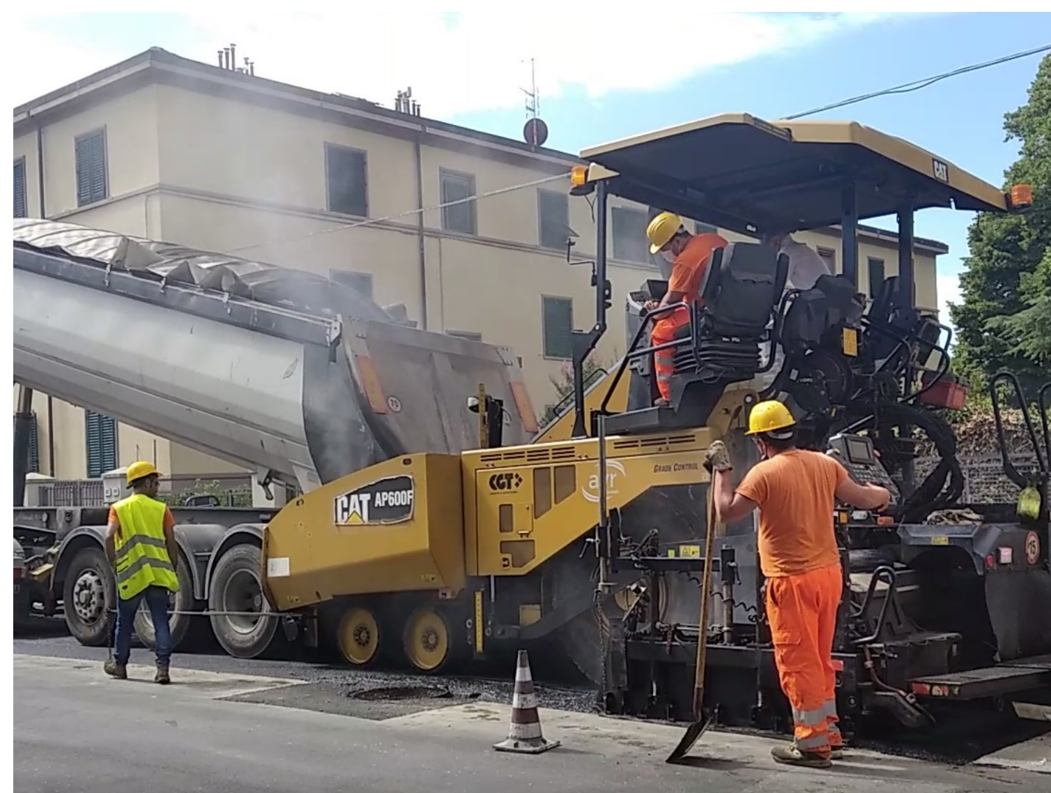
Stesura nuovo asfalto
