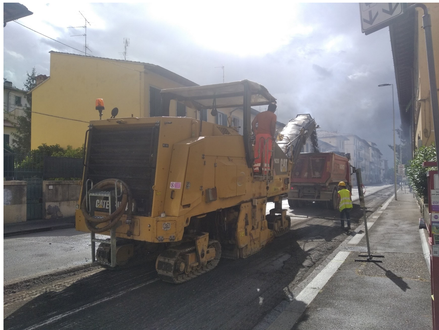
Entfernung des Altbelages
