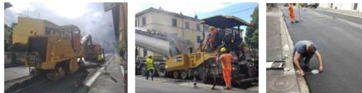
Entfernung des Altbelages
