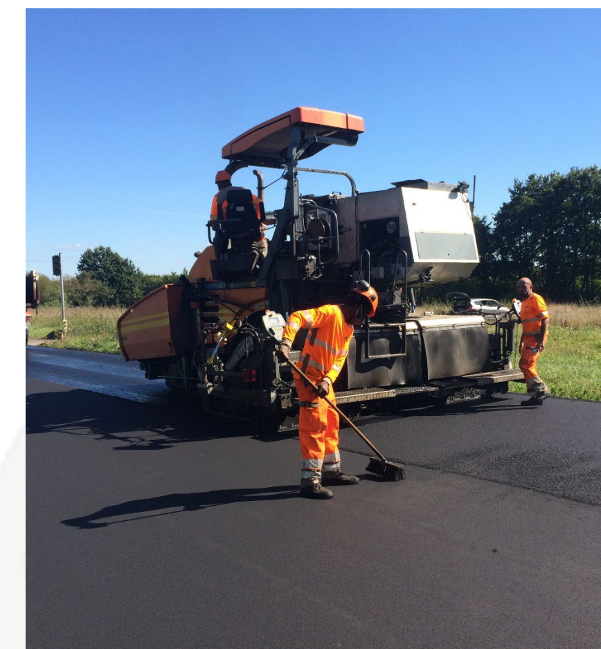
Mise en œuvre de l'enrobé : sous-couche (à gauche), couche superficielle en BBTM 0/6 (à droite)
