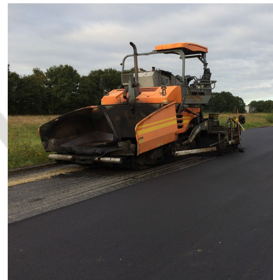
Mise en œuvre de l'enrobé : sous-couche (à gauche), couche superficielle en BBTM 0/6 (à droite)
