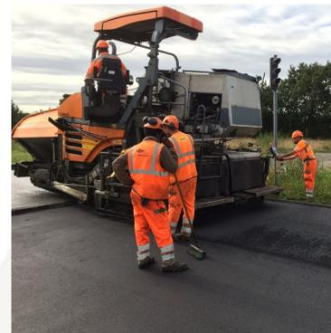
Asphaltierung: Tragschicht (links), Deckschicht in BBTM 0/6 (rechts)
