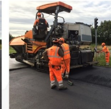
Asphaltierung: Tragschicht (links), Deckschicht in BBTM 0/6 (rechts)
