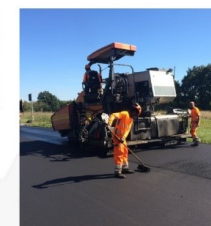
Posa del conglomerato bituminoso: sottofondo (sinistra), strato superficiale in BBTM 0/6 (destra)
