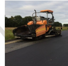
Asphaltierung: Tragschicht (links), Deckschicht in BBTM 0/6 (rechts)
