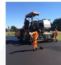
Mise en œuvre de l'enrobé : sous-couche (à gauche), couche superficielle en BBIM 0/6 (à droite)
