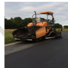
Mise en œuvre de l'enrobé : sous-couche (à gauche), couche superficielle en BBIM 0/6 (à droite)
