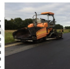
Posa del conglomerato bituminoso: sottofondo (sinistra), strato superficiale in BBTM 0/6 (destra)
