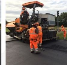
Asphaltierung: Tragschicht (links), Deckschicht in BBTM 0/6 (rechts)
