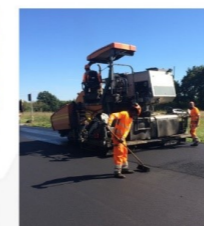
Posa del conglomerato bituminoso: sottofondo (sinistra), strato superficiale in BBTM 0/6 (destra)
