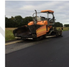
Asphaltierung: Tragschicht (links), Deckschicht in BBTM 0/6 (rechts)
