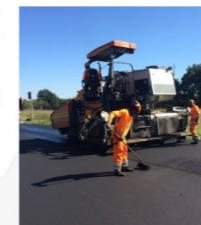
Mise en œuvre de l'enrobé : sous-couche (à gauche), couche superficielle en BBIM 0/6 (à droite)
